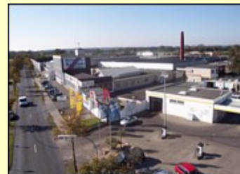
Abb. 4/1: Beispiel eines Gewerbegebiets
